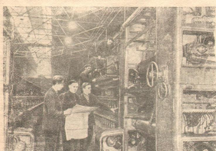
**Ленинград.** Завод имени Карла Маркса приступил к серийному производству машин для изготовления шелка из синтетического волокна-хлорина. Производительность каждой машины — 420 килограммов шелка в сутки.
